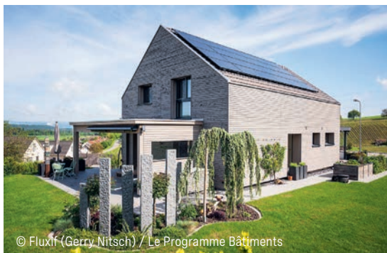
Ce bien immobilier, situé à Würenlingen (AG) et construit en 1961, a fait l'objet d'un assainissement énergétique particulièrement réussi.
